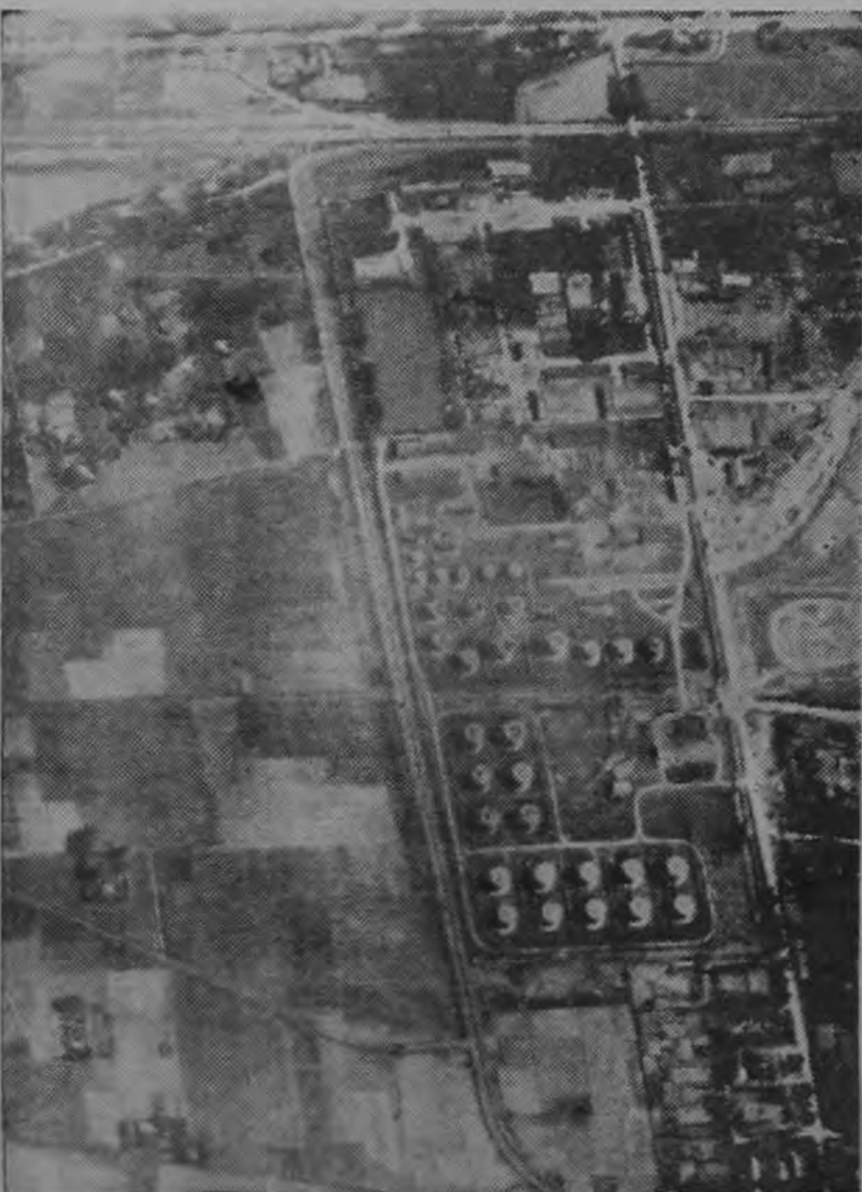
ANTES DEL ATAQUE — Esta fotografía de reconocimiento tomada antes del 29 de junio muestra la enorme instalación de almacenaje de petróleo, gasolina y lubricantes localizada a unos cinco kilómetros y medio al norte de Hanoi. Esta instalación era el segundo depósito de almacenamiento en tamaño en Vietnam del Norte y representaba una quinta parte de la capacidad nacional total. Incluía 32 tanques grandes y 8 pequeños, almacenes, casa de bombas y otros edificios auxiliares.
